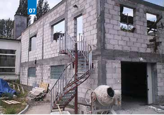
07 Klatka schodowa - ewakuacyjna, 2003
